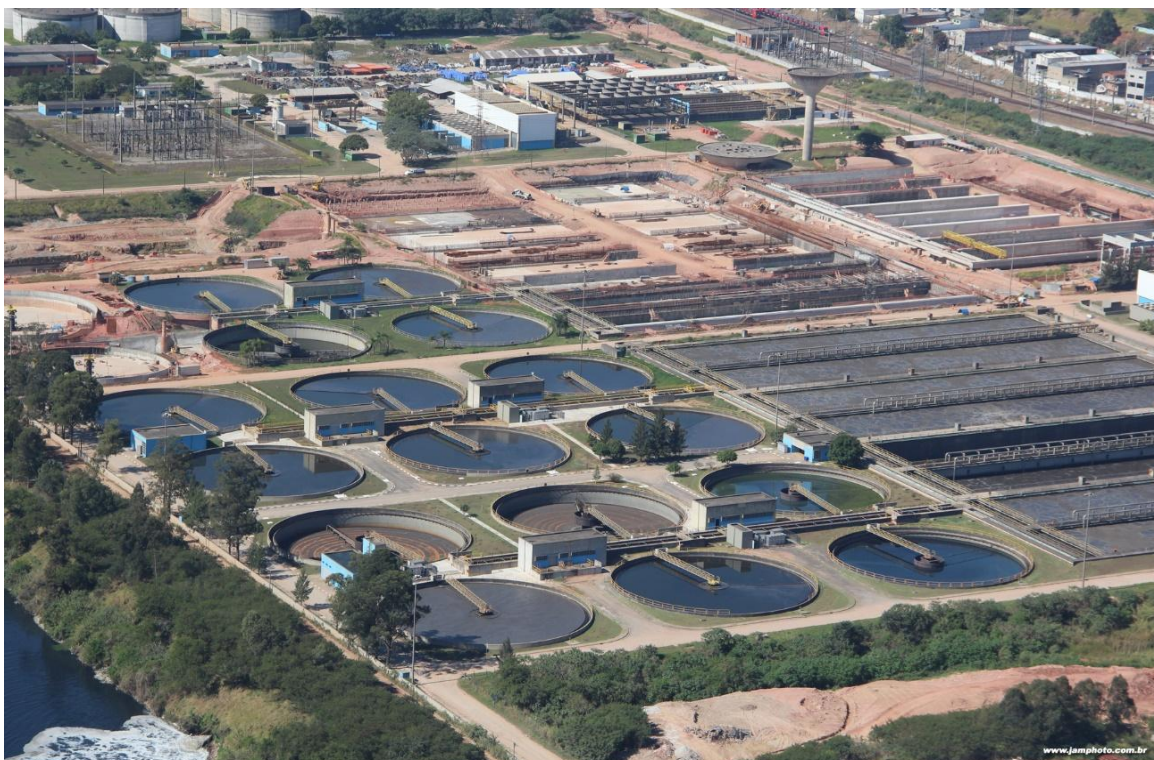
Figura 2 - Vista Geral da ETE Barueri.
