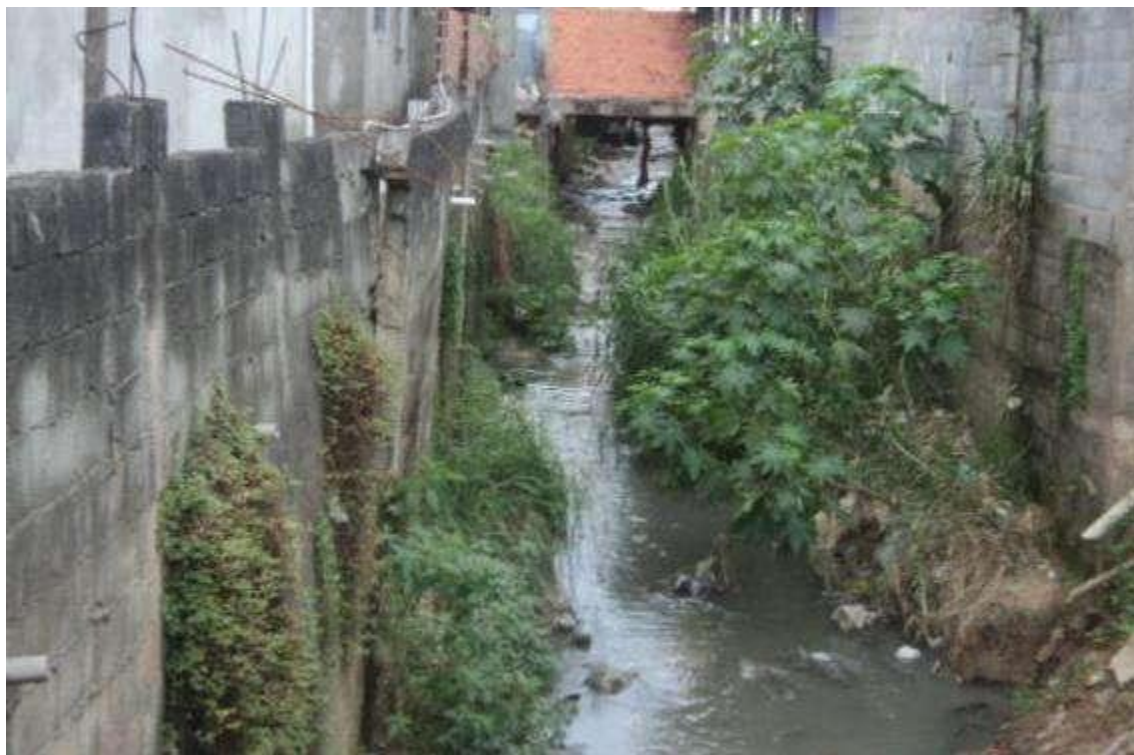
Figura 8 – Córrego com margens ocupadas na Vila Iza
