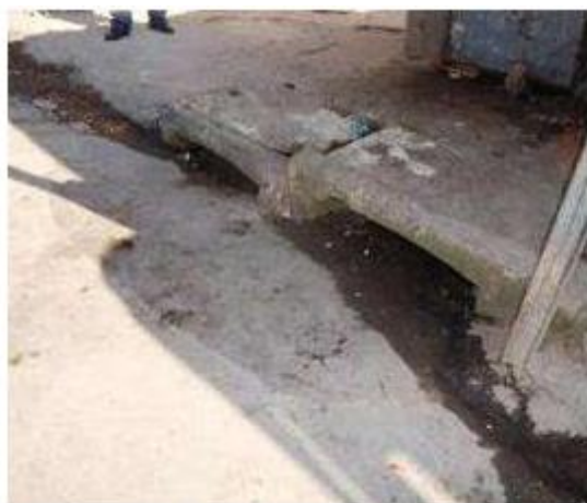
Figura 12 - Detalhe de Boca de Lobo
